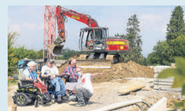
René Petrak besichtigt die Baustelle mit Rosmarie Bättscher, Reto Kronenberg und Josef Waser.
